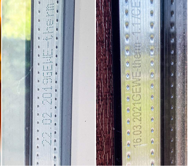
Viele erneuerte Türen und Fenster
